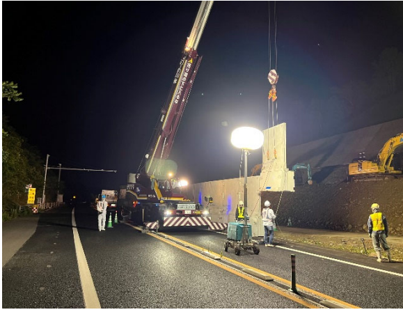
＜仮設防護柵設置＞
