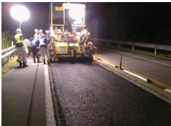
＜舗装補修工事＞
