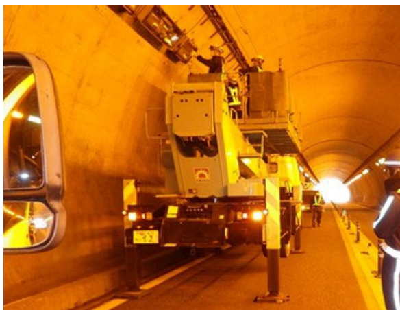
＜トンネル照明灯具点検・取替工事＞
