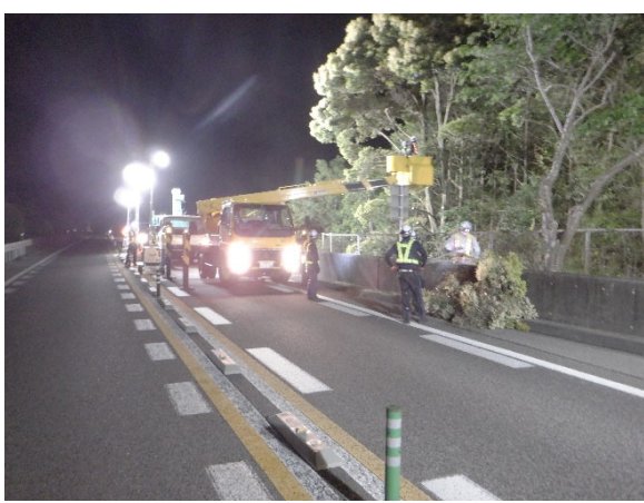
＜樹木伐採作業＞
